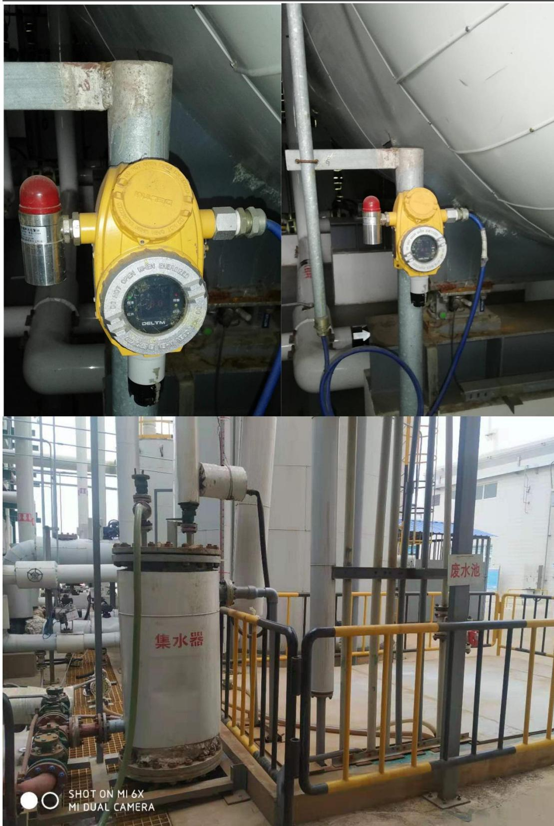
图 4.1-6 该项目报警器、集水器及围堰
