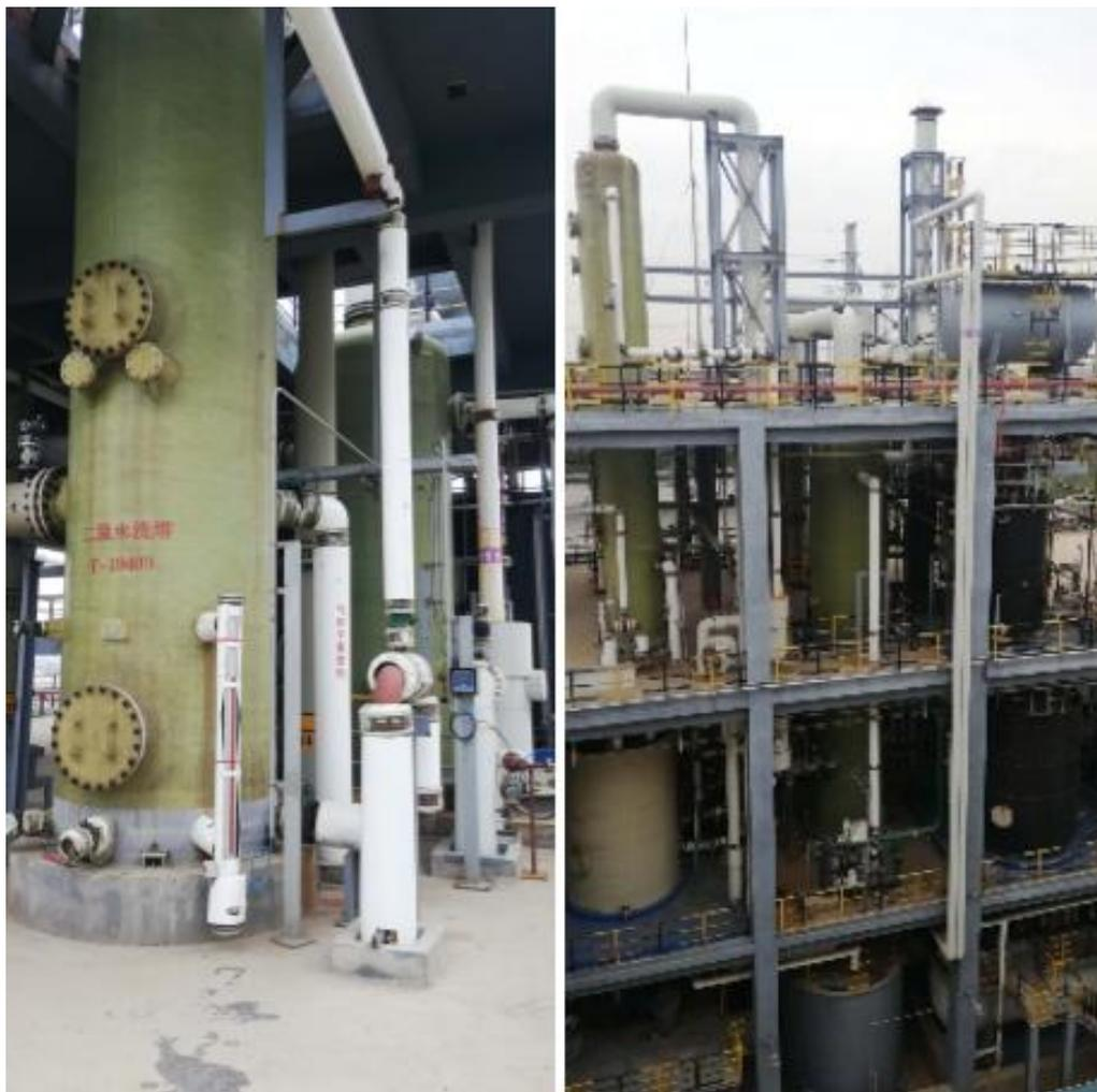
图 4.1-4 该项目二级水洗+二级碱洗处理设施及排气筒
