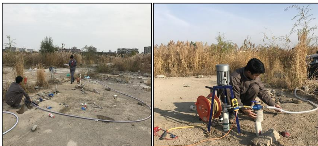
图 3-21 本项目抽水试验现场工作
