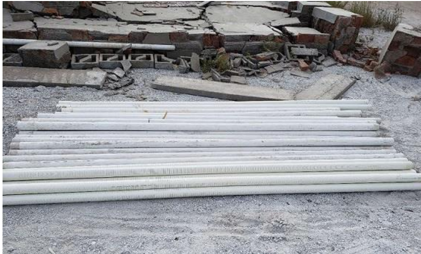
图 6-9 本项目使用井管与滤水管
