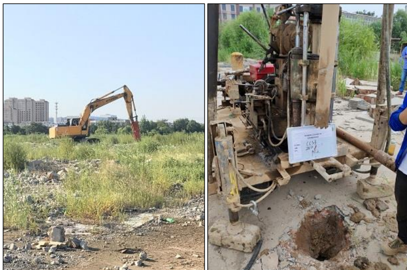
图 6-5 点位表层硬化破碎
