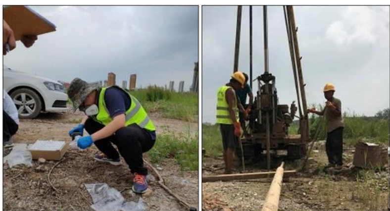
图 6-20 现场采样与钻探人员安全防护
