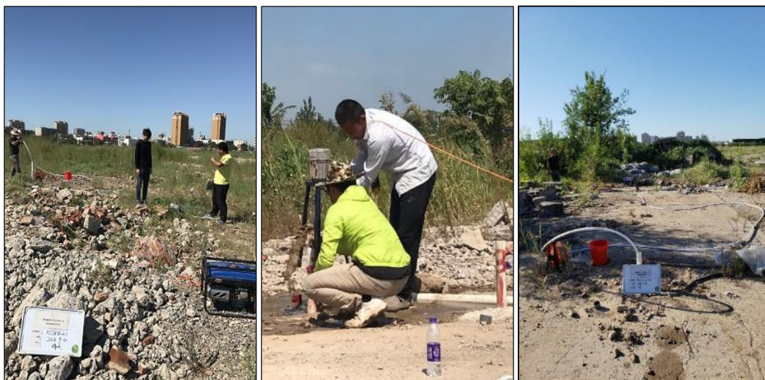
图 6-10 螺杆自吸泵洗井
